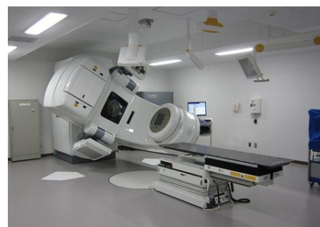
奈良県立医科大学附属病院 E病棟 放射線治療室
