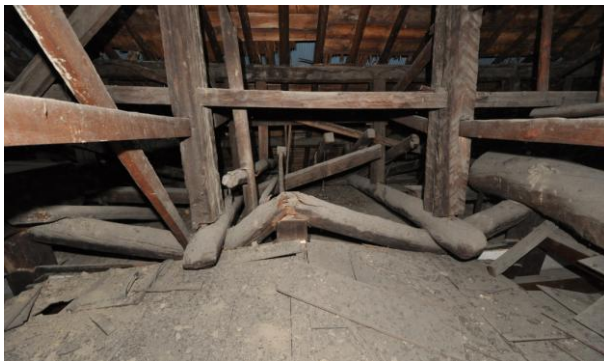
<破損状況> 左；小屋梁折損状況 右；突き破られた天井
