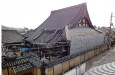
本堂・鐘楼・土塀
