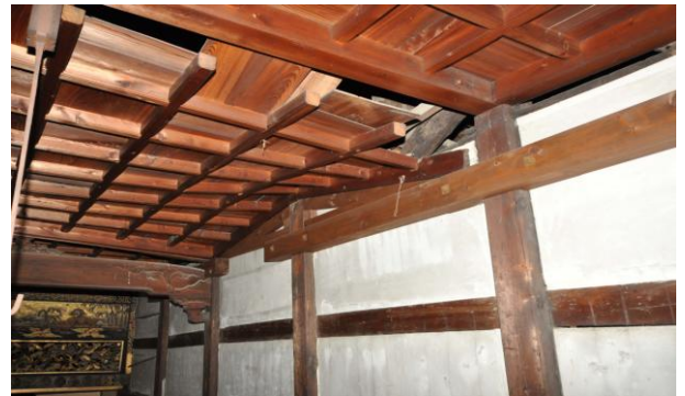
<破損状況> 左；小屋梁折損状況 右；突き破られた天井
