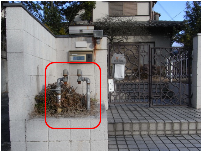
ガスメーターの撤去事例
