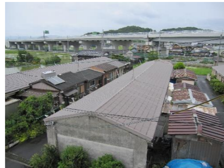
老朽化した御所茅原団地
