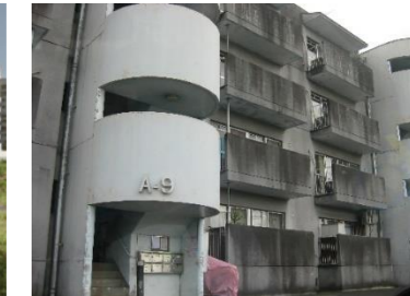
コンクリートの中酸化が進み躯体の劣化が懸念 / 榎原団地
