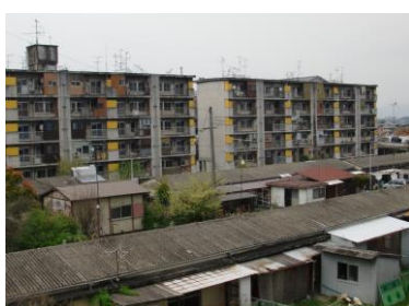
建替予定の老朽化した団地
