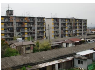
建替予定の老朽化した団地
