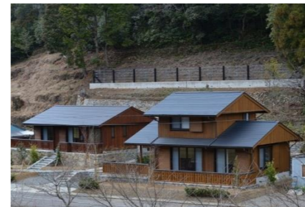
<十津川村復興住宅>
