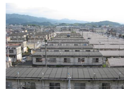
<桜井県営住宅>
