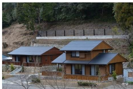
<十津川村復興住宅>
