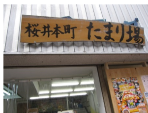
空家改修による地域活動拠点整備
