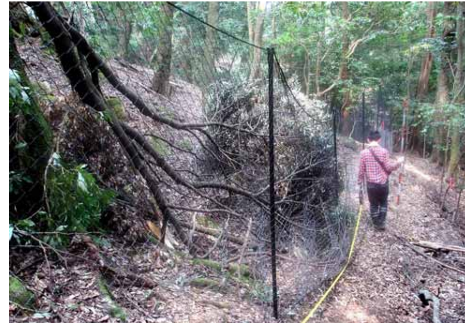
【写真1】保護柵周辺の枝折れ
