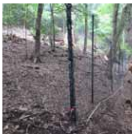
植生保護柵の設置
