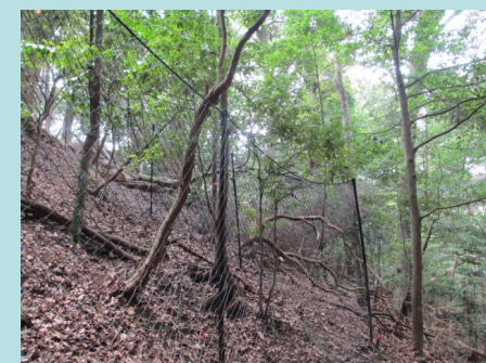
▲植生保護柵の設置
