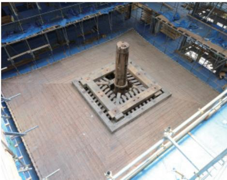
三重側柱解体後（柱盤には柱の痕跡が残っています）
