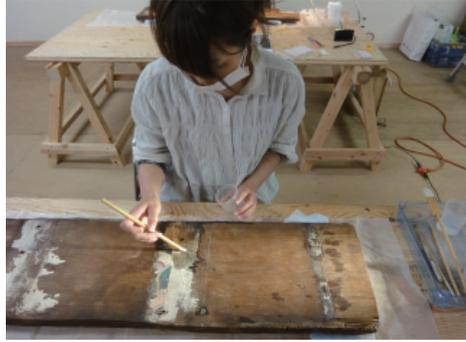
初重天井板の剥落止め作業
