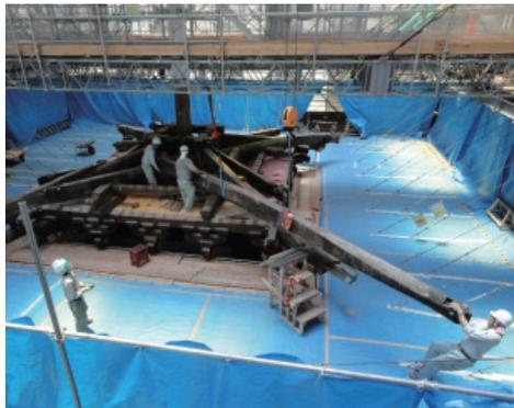
明治補強材の解体（時にはクレーンの力も借ります）
