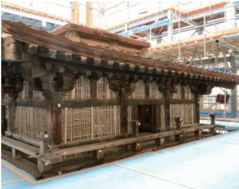
裳階壁土解体後（上の心柱を解体し、裳階の解体開始）
