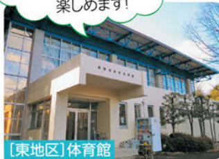
[東地区] 体育館
