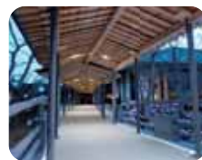
両建物をつなぐ渡り廊下
