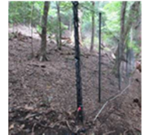
植生保護 柵の設置 状況
