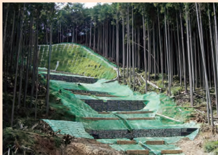
曾爾村（長野地区）山腹工事完成
