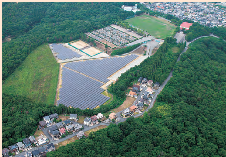
県内事業者によるメガソーラー発電所
