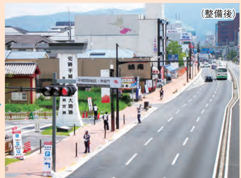
道路の無電柱化（大宮通り）
