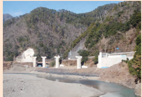
紀伊半島アンカールートの整備（川津道路）
