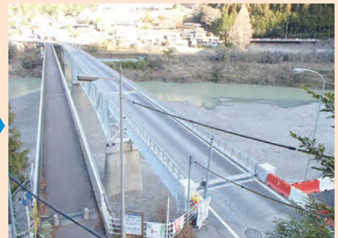
十津川村「折立橋」(平成26年1月復旧)
