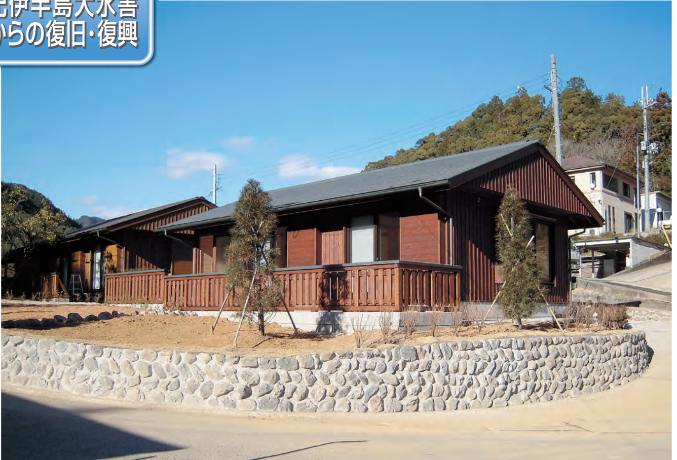
建設が進む十津川村の復興住宅（十津川村猿飼地区）
