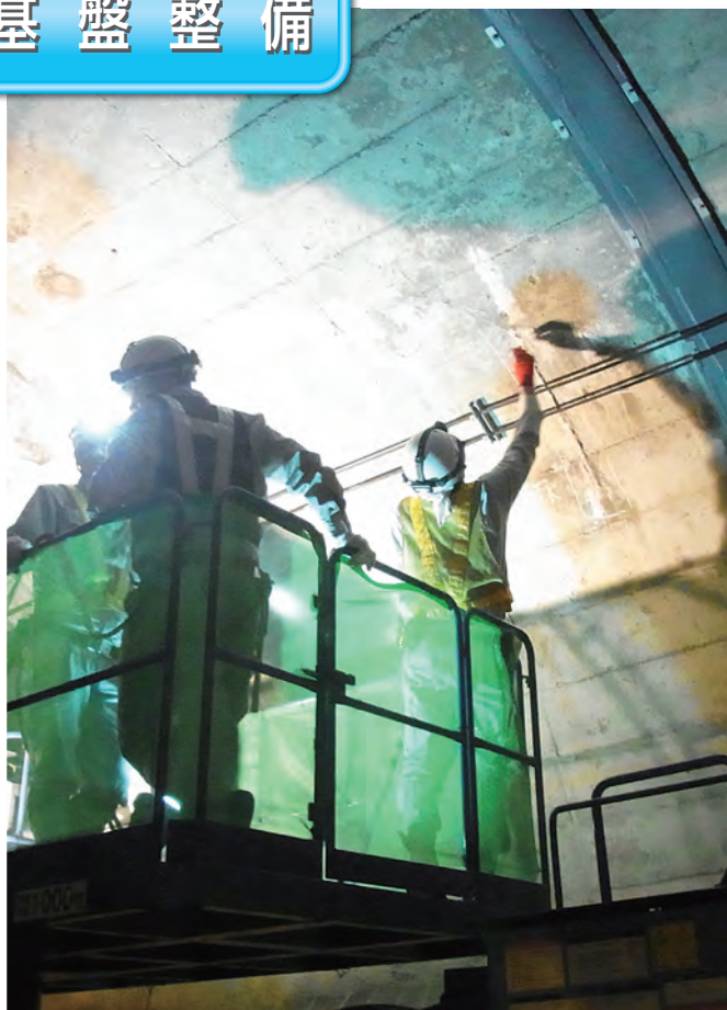
トンネル点検状況
