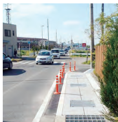
通学路の安全対策 対策後
