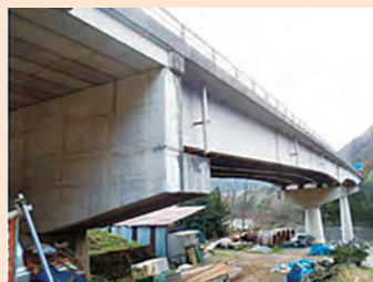
宮滝大橋の補修前
