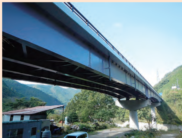
宮滝大橋の補修後
