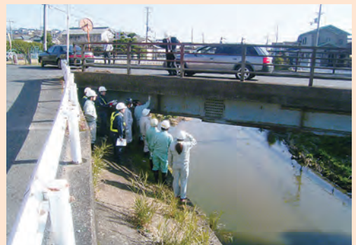
道路橋梁点検
