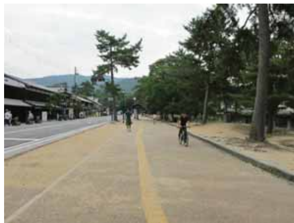
北側園路部分。道路改修直後で樹木がない。
