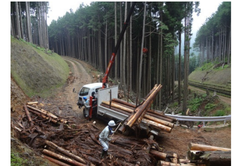
クレーン積み込み
