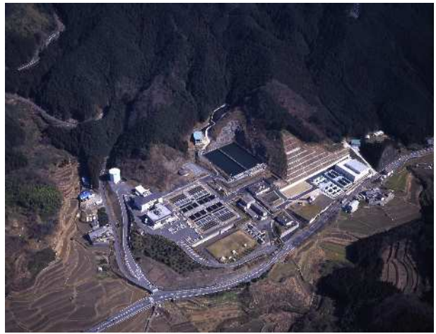
さくらい 《桜井浄水場》 水源: 室生ダム 1日最大給水量: 130,000 m^3 /日 1974年(昭和49年)運転開始
