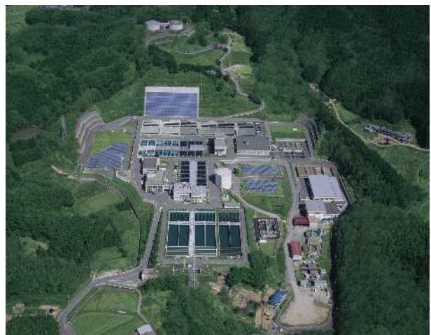
ごせ 《御所浄水場》 水源: 大滝ダム、大迫ダム、津風呂ダム 1日最大給水量: 370,000 m^3 /日 1970年(昭和45年)運転開始
