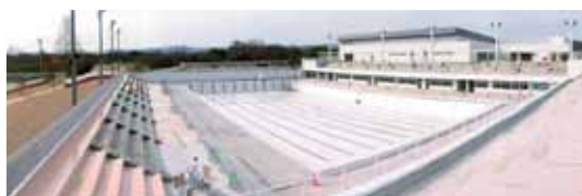
工事中のスイミア奈良(平成26年3月)
