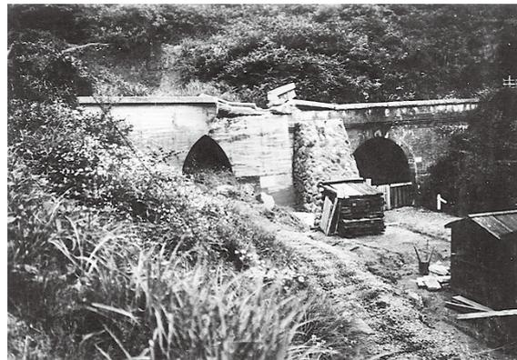
地すべりの影響で崩落した亀の瀬トンネル
