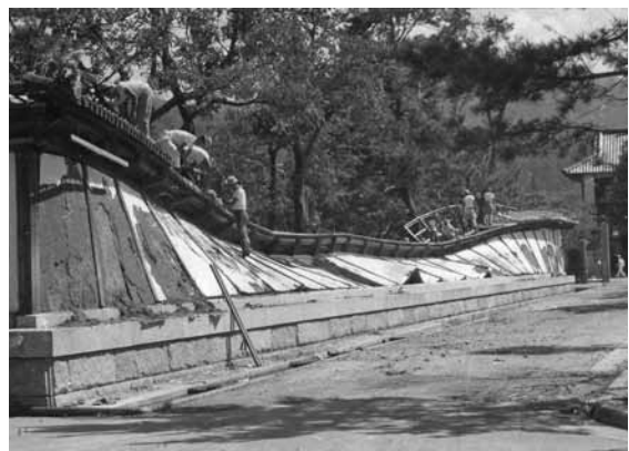
倒れた土塀の後片付け。天理市内にて
