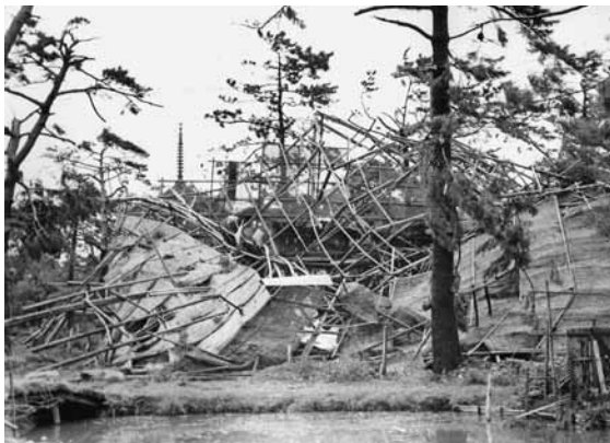
改修中だった興福寺大湯屋（写真提供：奈良新聞社）
