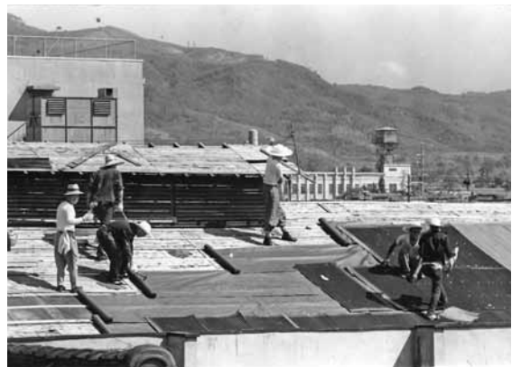
屋根ふきをする奈良市内の映画館
