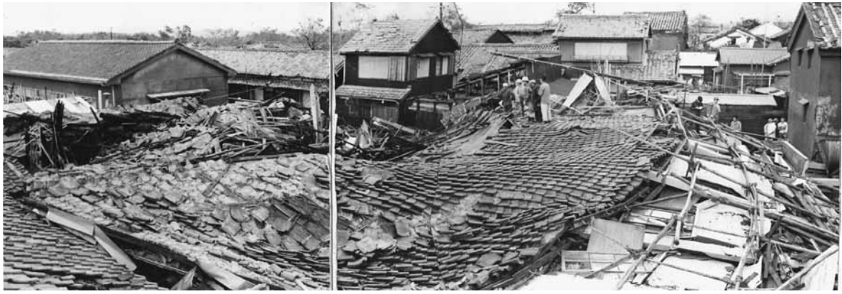
倒壊した般若寺の集合住宅（写真提供：奈良新聞社）
