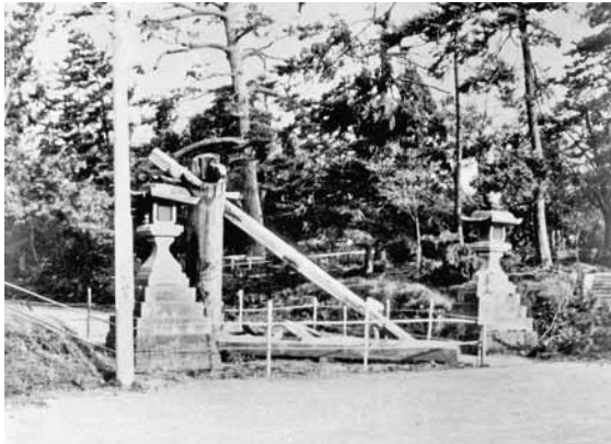
倒壊した春日大社一の鳥居 （『春日大社一の鳥居他一棟災害復旧工事報告書』より）
