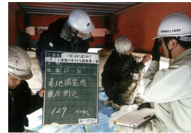
県職員と市町村職員による現場立会状況
