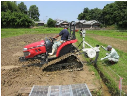
弾丸暗渠による排水改善
