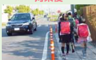
奈良市立平城小学校区 (事業主体 奈良県) 側溝に蓋かけし、歩道の幅が広げられ、安全な通学路を確保
