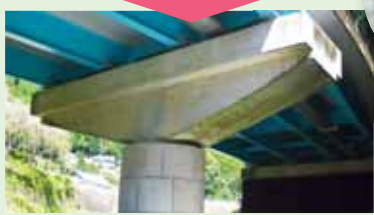
国道169号 音無橋(川上村西河) 老朽化した橋桁の塗装や、橋脚を補強して長寿命化を図る
