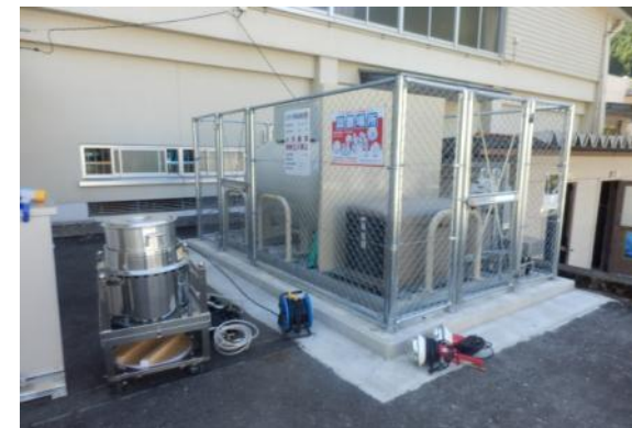
LPガス発電機の整備(十津川村)
