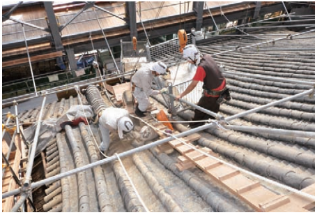
屋根瓦解体中
