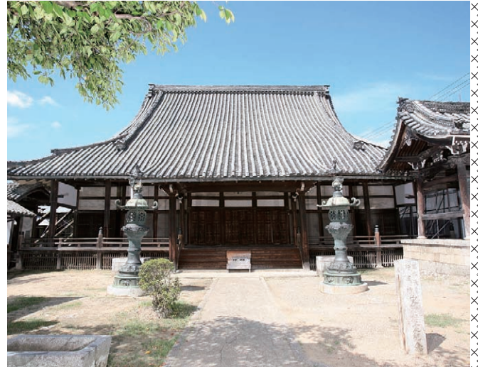
本堂 正面（解体前）
