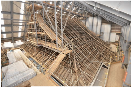
屋根解体完了
