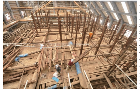
小屋組解体中（下段）
