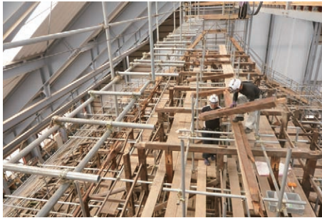
小屋組解体中（上段）
