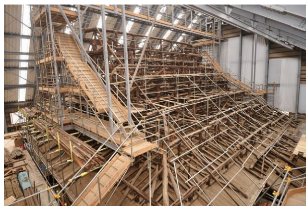
小屋組 南東から
