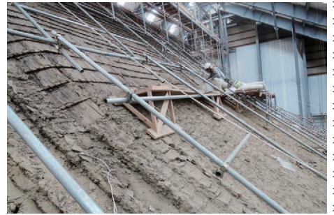
屋根葺土解体中
