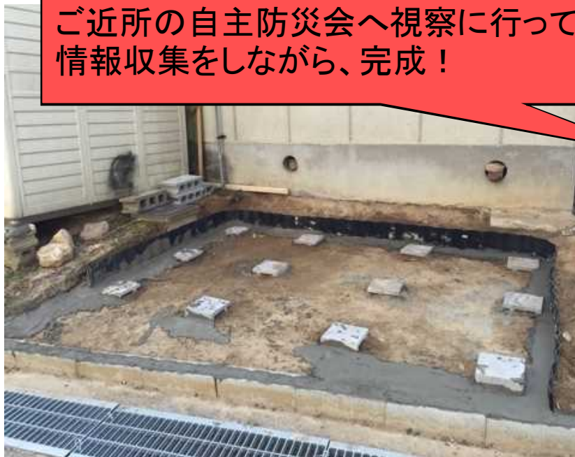
【防災倉庫】基礎工事のようす
