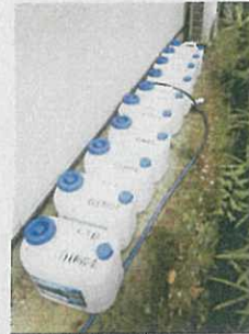
備蓄雑用水タンク
