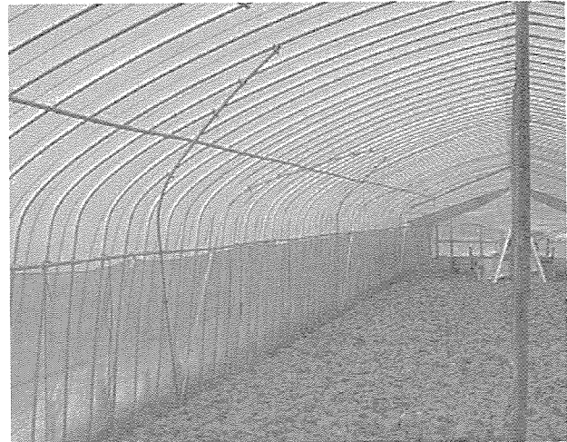
第 13 図 天井部に届いていない筋交い
