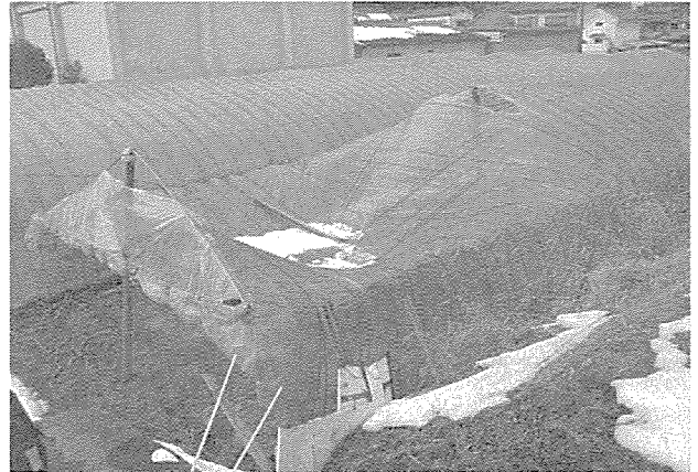
第9図 支柱に傷があることで折れ、その部分だけが倒壊したハウス
