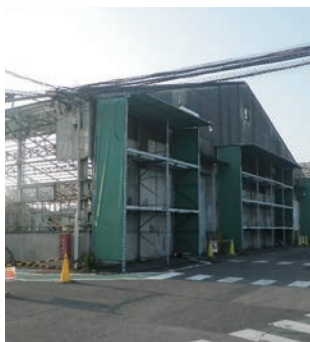
撤去が始まった積水化学工業
