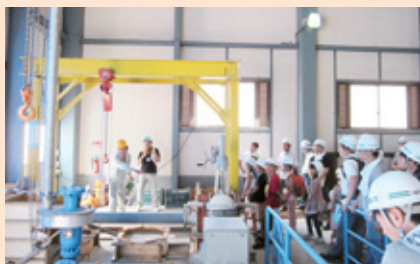
上津ダム見学会内での小水力発電の説明（山添村）
