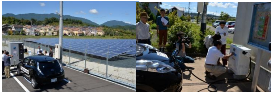
住民参加によるEVから避難所への電力供給訓練
