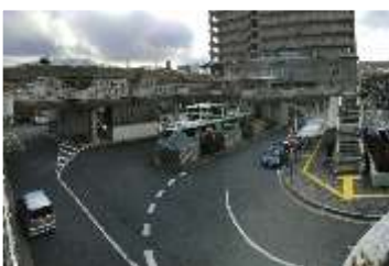
北口駅前広場の状況
