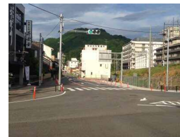
国道165号（萩原交差点東側） 《片側歩道整備済、暫定供用中》
