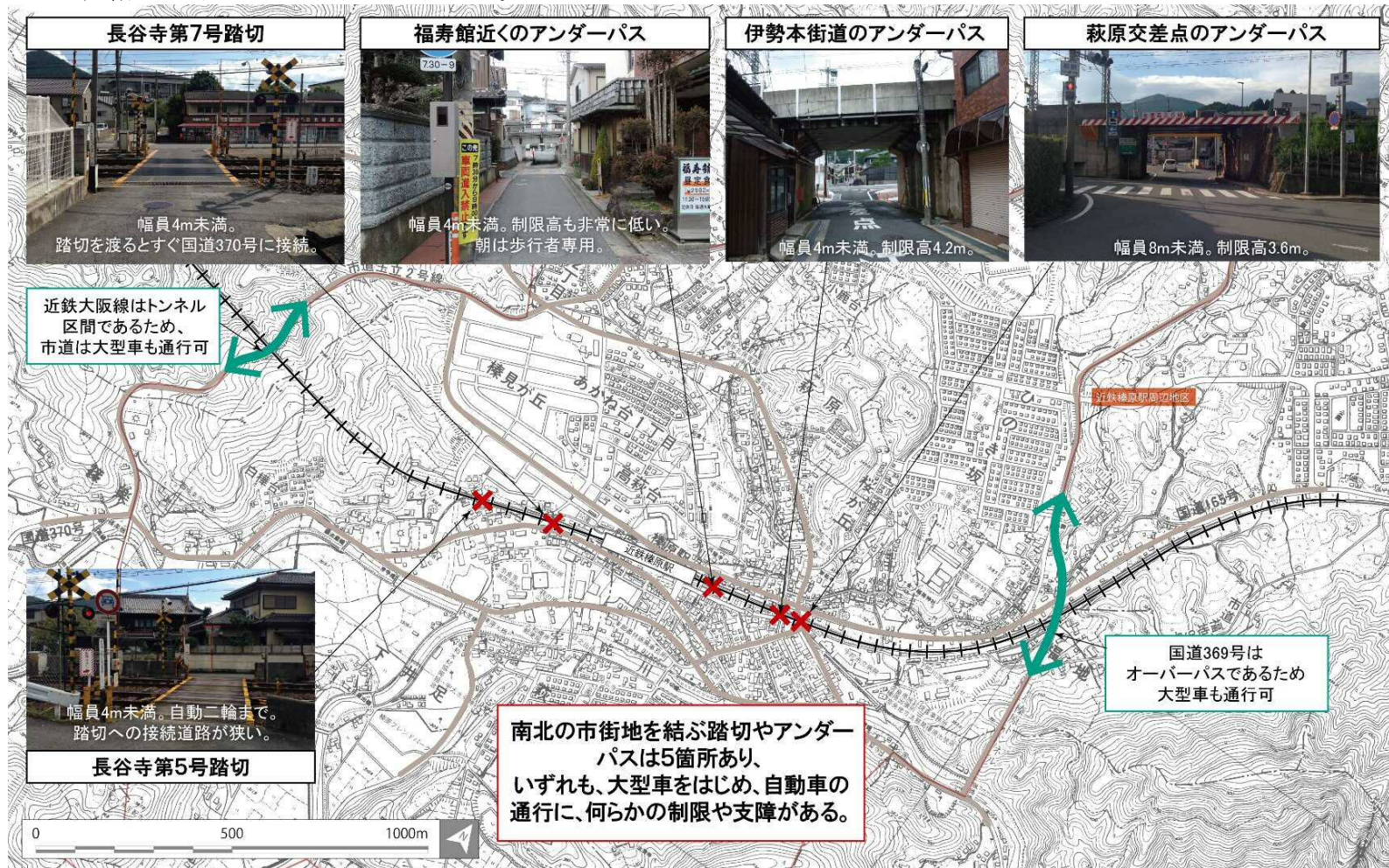
図 南北市街地を結ぶ道路の状況
