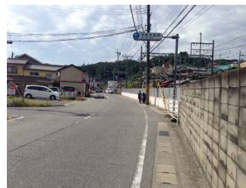
国道370号（駅前から西側）
