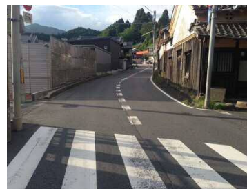
国道165号（萩原交差点北側） 《整備中》
