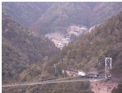
◆谷瀬の吊り橋
