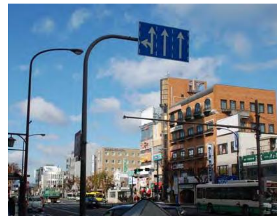
【写真3】駅周辺の屋外広告物等の状況
