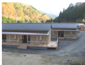
野迫川村北股の応急仮設住宅
