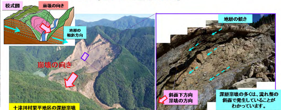
「深層崩壊のメカニズム解明に関する現状報告(平成25年2月版)」より抜粋
