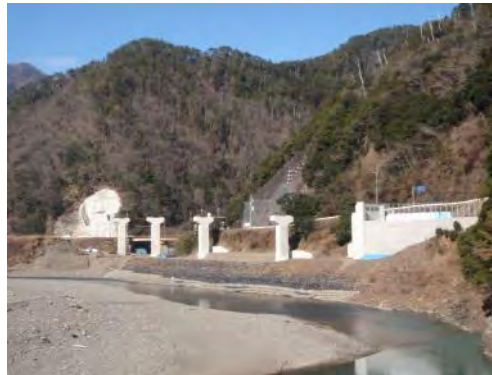
(川津道路) 施工状況
