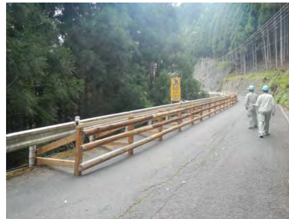
防護柵(完成) 平成25年5月16日撮影
