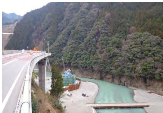
(十津川道路) 折立地区の施工状況
