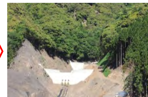
平成25年5月24日撮影 2号・3号谷止工(完成)
