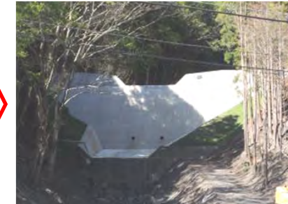
平成25年5月24日撮影 1号谷止工(完成)
