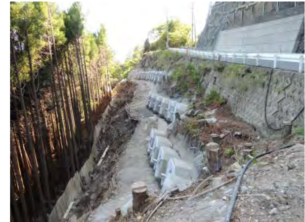
第1期アンカー工(完成) 平成25年5月24日撮影
