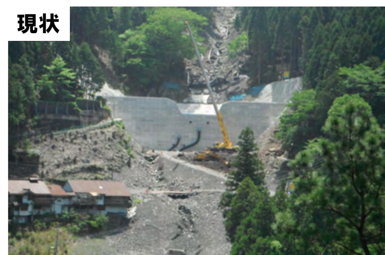
本堰堤工の整備状況(本体完了) 平成25年5月24日撮影 8
