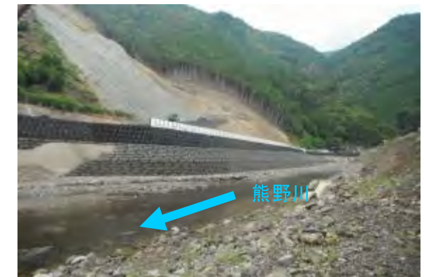
平成25年8月22日撮影 (河川堆積土砂暫定掘削完了)
