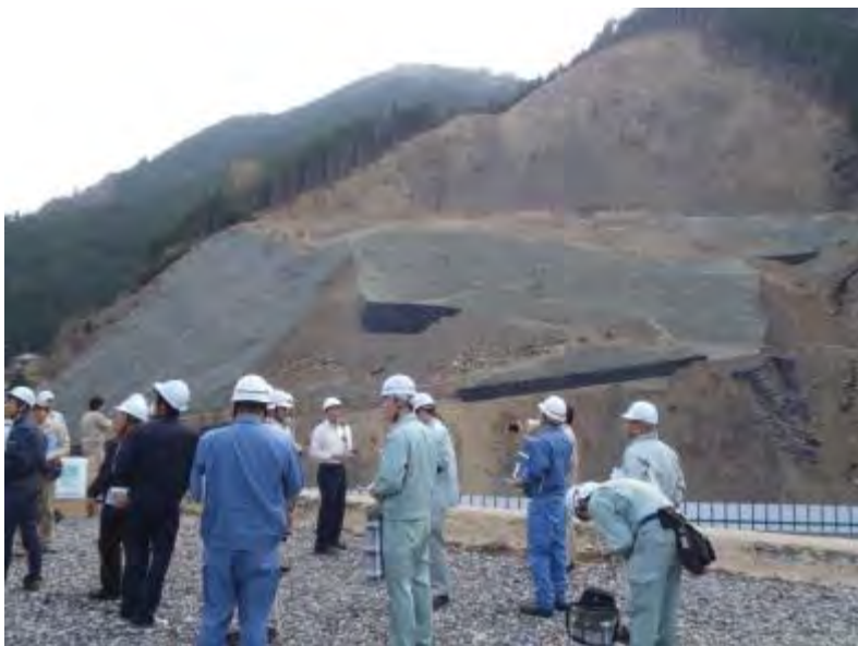
深層崩壊研究会メンバーによる深層崩壊の現地確認状況(五條市大塔町)
