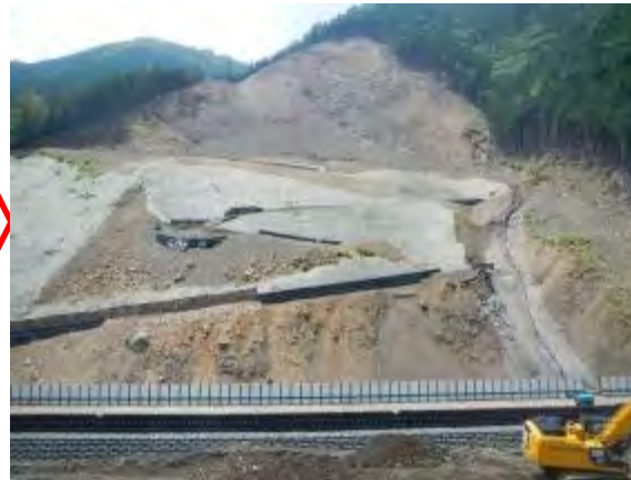
平成25年8月5日撮影(斜面对策状況)
