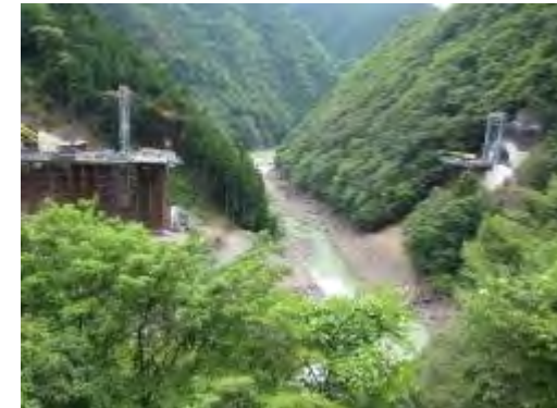
(辻堂バイパス) 新猿谷トンネル南側付近の施工状況
