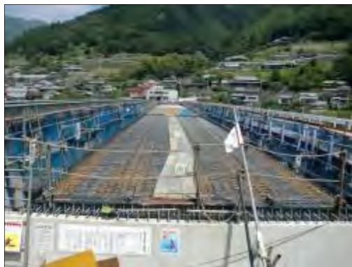
平成25年8月16日撮影 現在、橋梁上部工工事を推進中 (床版工)
