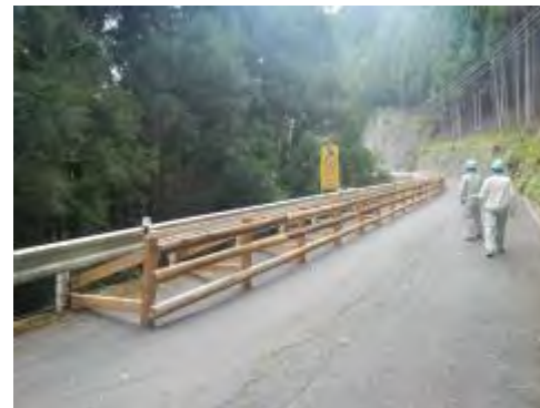
防護柵（完成） 平成25年5月16日撮影
