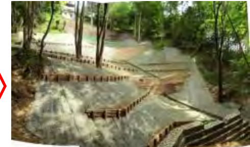
平成25年6月14日撮影 山腹工(完成)
