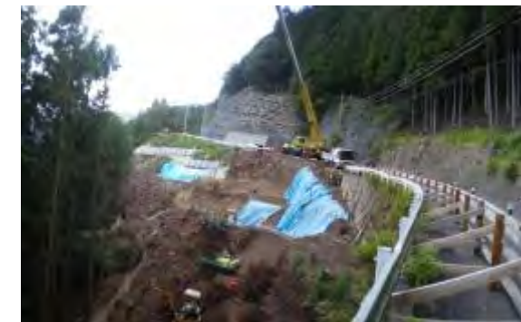
土砂掘削（作業中） 平成25年8月20日撮影
