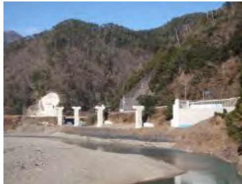
(川津道路) 施工状況
