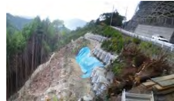
支障木伐採搬出済み 平成25年8月20日撮影
