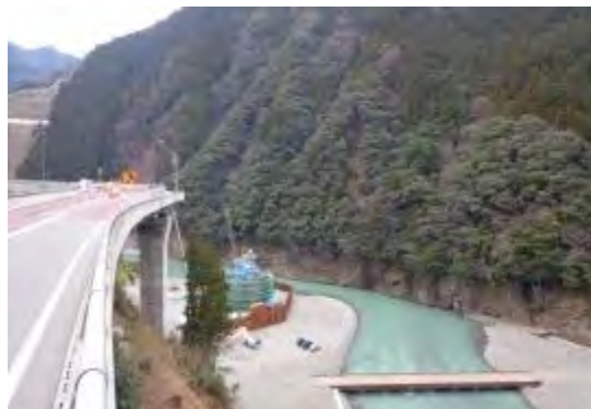
(十津川道路) 折立地区の施工状況
