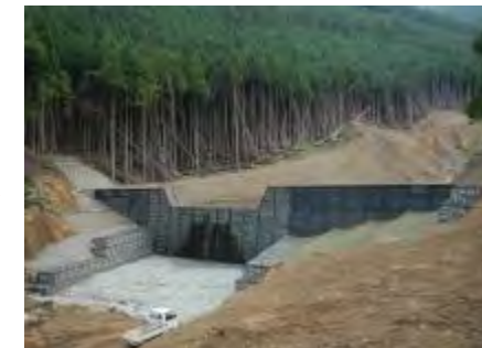
平成25年8月2日撮影 3号谷止工(完成)
