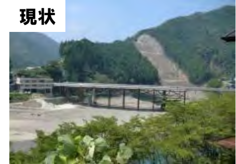
平成25年8月16日撮影 現在、橋梁上部工工事を推進中 (桁架設完了)
