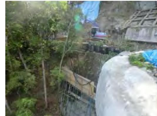
市道災害復旧工事(奥:法面工、手前:ブロック積工)
