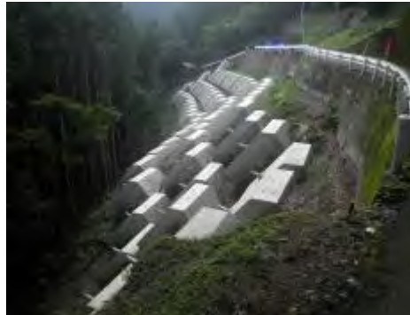
【天川村広瀬地区：地すべり対策】
