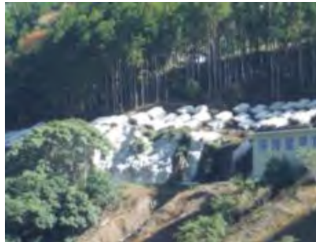
【十津川村小井地区：地すべり対策】
