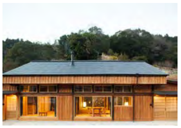
隊員が管理運営する旧教員住宅を改修した宿泊施設「大森の郷」（十津川村）
