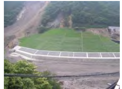
【十津川村宇宮原地区：地すべり対策】
