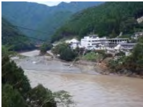
【熊野川 十津川村武蔵地区：護岸損傷】
