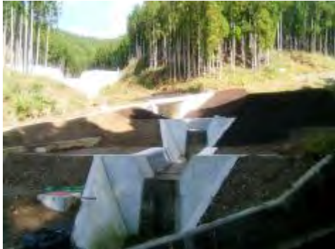
【御杖村土屋原地区：土石流対策】
