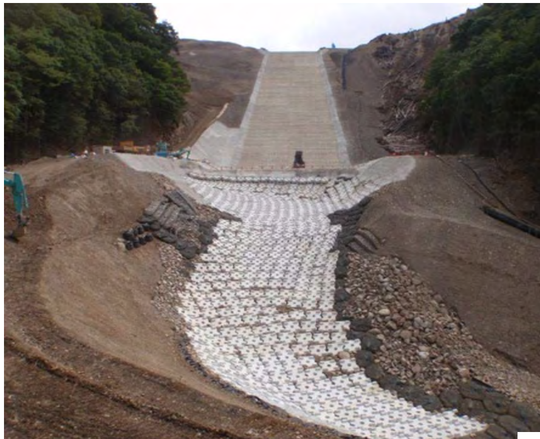
十津川村栗平地区の工事状況 (2012年8月24日現在)
