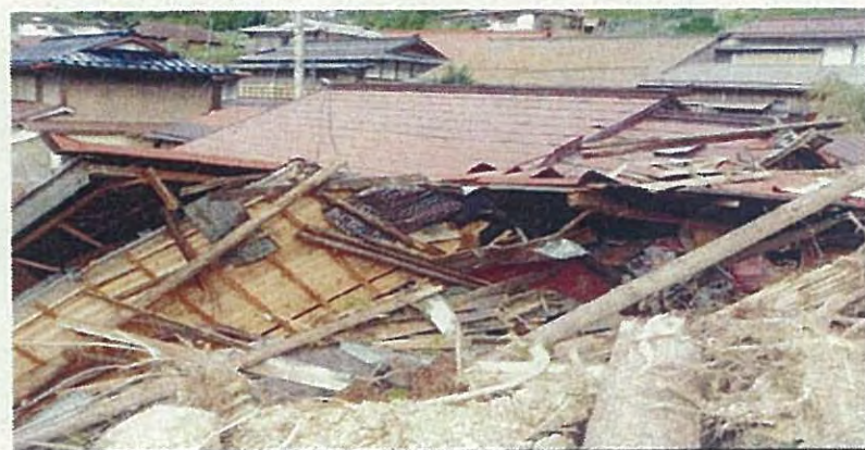
紀伊半島大水害による建物被害
