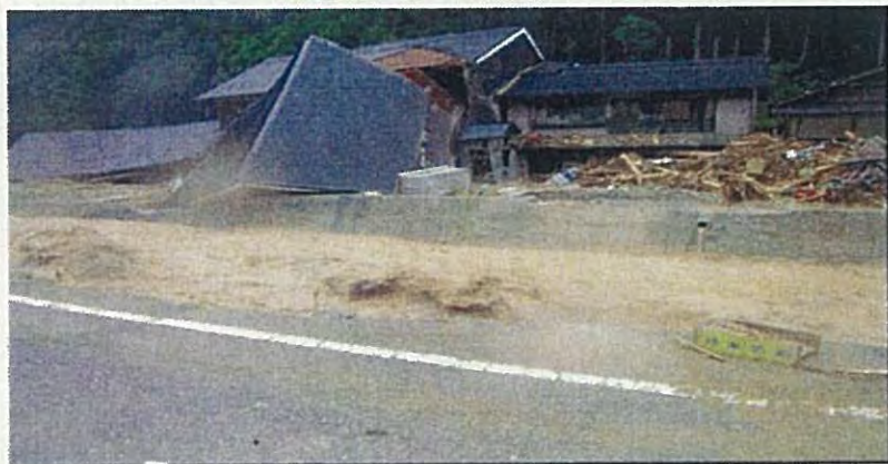
紀伊半島大水害による建物被害
