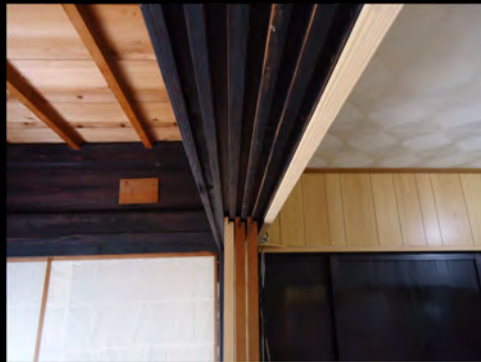
22 4本溝の差し鴨居により建具を開放し 大人数の集まりや通風に対応
